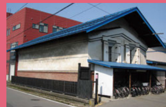
10 鎌田屋商店 (蔵) [和徳町 3-1 昭和 10 年建築] 大正 8 年創業の海鮮物問屋の老舗。土淵川沿いに建つ蔵は、現在では事務所兼倉庫として活用されています。
