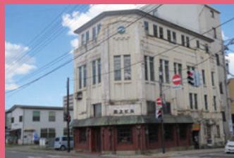
06 三上ビル (旧弘前無尽社屋) [元寺町 9 昭和 2 年建築] 登録有形文化財。東北でも初期の鉄筋コンクリート造の建物。アールデコ調のデザインが洒落た社屋ビルです。
