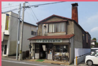
01 保村打刃物製作所 [代官町 68-2 昭和 38 年建築] 旧羽州街道沿いにある煙突が特徴的な建物。さびない牛刀包丁などを製作する津軽打刃物職人の店です。
