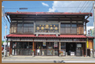
34 有限会社(農)高木静一商店 【松森町158 昭和4年建築】 金文字看板が老舗の風格と趣を添えている肥料・農薬店。漆喰の天井や観音開きの窓など、昭和のまま時の流れが止まったようなたたずまいを見せている建物です。
