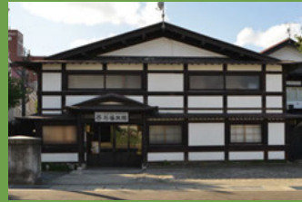
13 石場旅館 [元寺町 55 明治 12 年建築] 登録有形文化財。黒塗りの付け梁と白い漆喰壁が、城下町弘前の風情を醸し出している老舗の旅館です。
