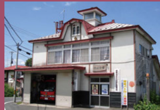
24 茂森会館消防西第一分団 [西茂森1丁目1 昭和11年建築] 禅林街入口の枳形に位置し、望楼付きの洋風デザインが目目を惹く建物です。
