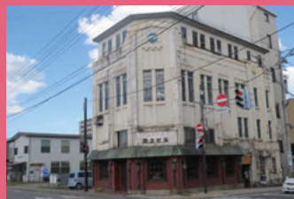
06 三上ビル (旧弘前無尽社屋) [元寺町 9 昭和 2 年建築] 登録有形文化財。東北でも初期の鉄筋コンクリート造の建物。アールデコ調のデザインが洒落た社屋ビルです。
