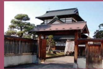
25 下山家住宅 [茂森新町3丁目1-3 昭和20年建築] 正面玄関側に切妻型の大きな屋根、白漆喰の妻壁に格子状の梁や束が美しい「吾妻建ち」の特徴を残した建物です。
