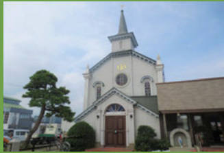
11 カトリック弘前教会 [百石町小路 20 明治 43 年建築] 堀江佐吉の弟、横山常吉が施工した尖塔をもつロマネスク様式の木造建築。神の救いの歴史を表現したステンドグラスが美しい彩を添えています。
