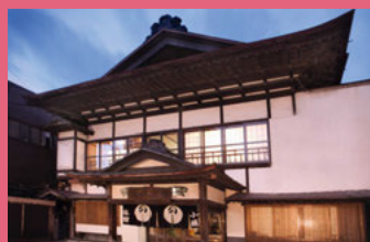
08 小堀旅館 [本町 89 昭和 3 年建築] 入母屋の大屋根と高い軒高が特徴的な建物。建物内の土蔵や暖簾など、歴史を感じさせてくれる老舗旅館です。
