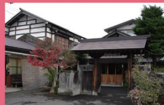
09 平野 [徒町川端町 7 大正期建築] 土淵川沿いにたたずむ門構えが目を引く建物。大正時代に民家として建てられた建物ですが、昭和 30 年から割烹として営業していました。
