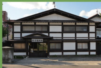
13 石場旅館 [元寺町55 明治12年建築] 登録有形文化財。黒塗りの付け梁と白い漆喰壁が、城下町弘前の風情を醸し出している老舗の旅館です。
