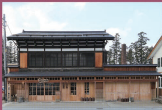
23 酒舗 成豊 [茂森町83 昭和7年建築] 禅林街の門前町、また相馬・目屋地区の街道沿いの町家。当時を感じさせる建物で、地酒も多く取り扱う老舗の酒店です。
