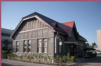
21 旧第八師団長官舎(弘前市長公舎) [上白銀町1-1 大正6年建築] 登録有形文化財。堀江佐吉の長男、堀江彦三郎の設計。大正時代の洋風高級住宅を彷彿させる建物です。現在はコーヒーストアとして活用され新たな観光スポットになっています。
