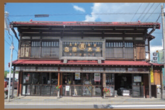
34 有限会社(農)高木静一商店 [松森町 158 昭和4年建築] 金文字看板が老舗の風格と趣を添えている肥料・農産物を営んでいた。漆喰の天井や観音開きの窓など昭和のまま時の流れが止まったようなたたずまいを見せている建物です。
