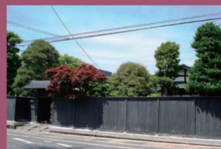
29 木村家住宅 [在府町1-1 江戸期建築] 藩政時代に上級武士が多く住んでいた在府町にある建物。薬医門、黒板塀、坪庭などの屋敷構えから家格の高い屋敷であったことがうかがえます。
