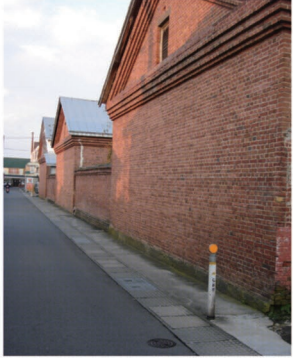
●弘前銘醸煉瓦倉庫と小道
