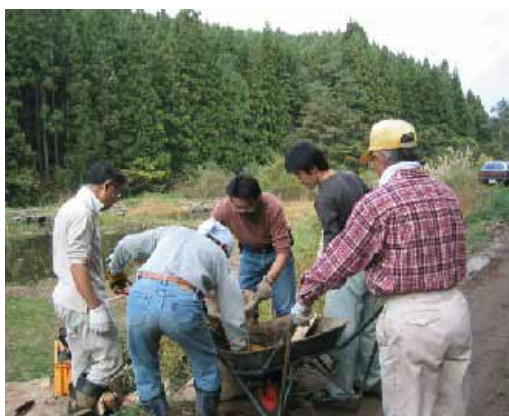
だんぶり池補修作業
