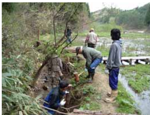
だんぶり池赤沢崩落箇所補修作業
