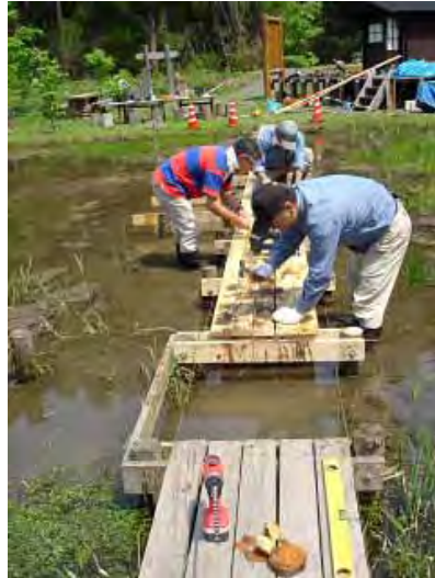
木道補修作業
