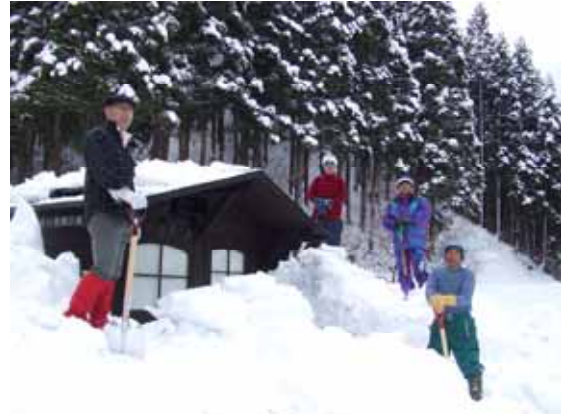
だんぶり池作業小屋雪降ろし
