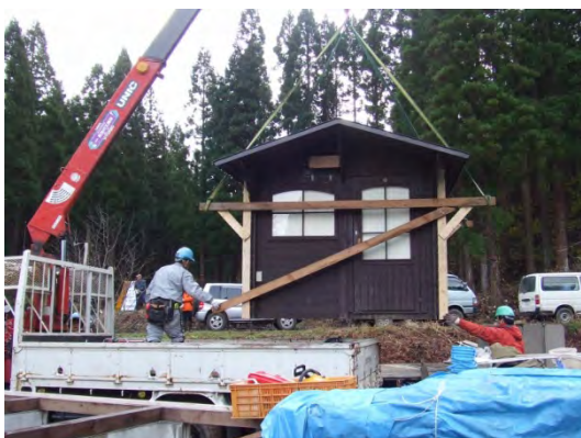
だんぶり池小屋移設作業
