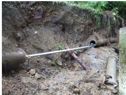
カナコ菴導水管敷設
