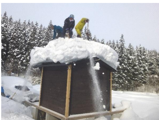
だんぶり池作業小屋雪下ろし
