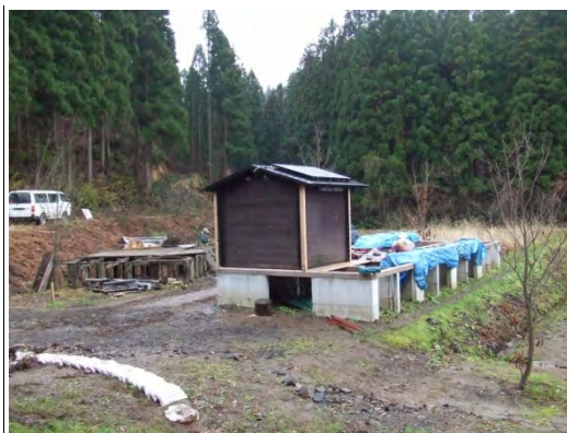
だんぶり池小屋移設完了
