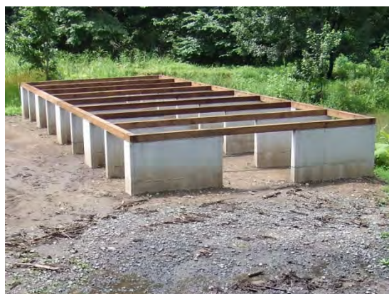
だんぶり池新デッキ基礎完成
