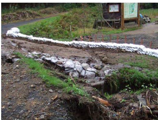
だんぶり池土嚢積み
