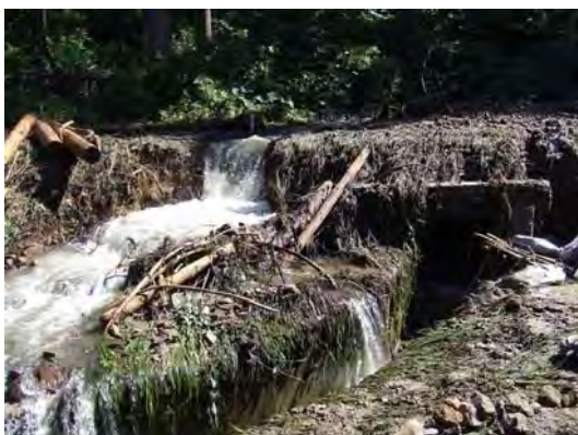
大畑沢取水口土砂流入閉塞状況
