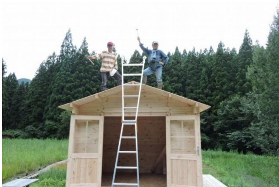
だんぶり池小屋キット組立完成
