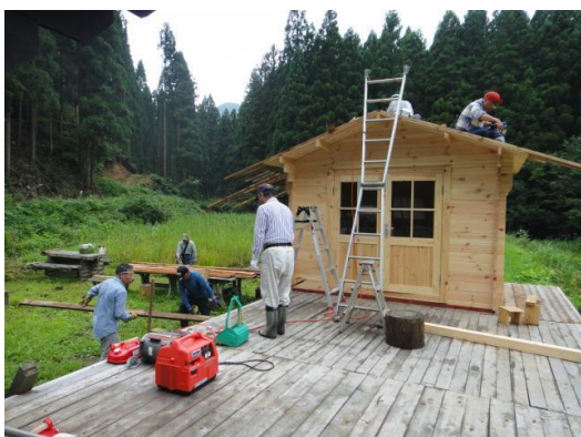
だんぶり池小屋屋根補強
