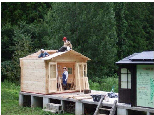
だんぶり池小屋キット屋根葺き
