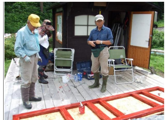
だんぶり池小屋キット底板防腐塗装
