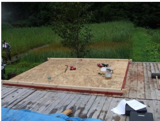
だんぶり池小屋キット底板据付
