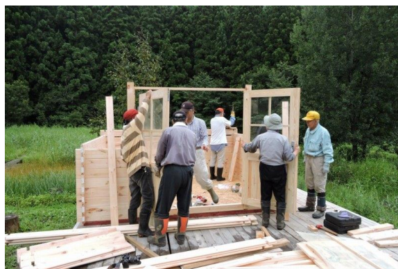
だんぶり池小屋キット側板組立
