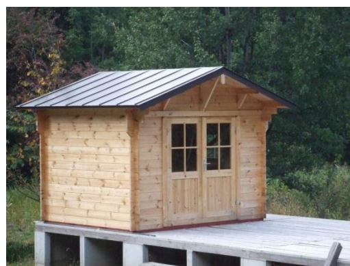
だんぶり池新設小屋屋根工事完成
