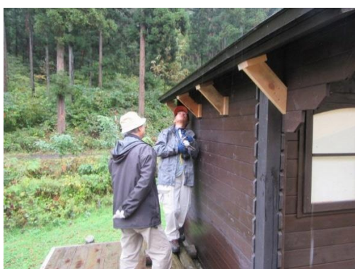
だんぶり池作業小屋軒下補強
