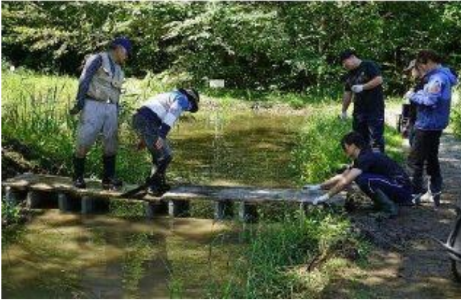
ウルメ池北側木道設置完了
