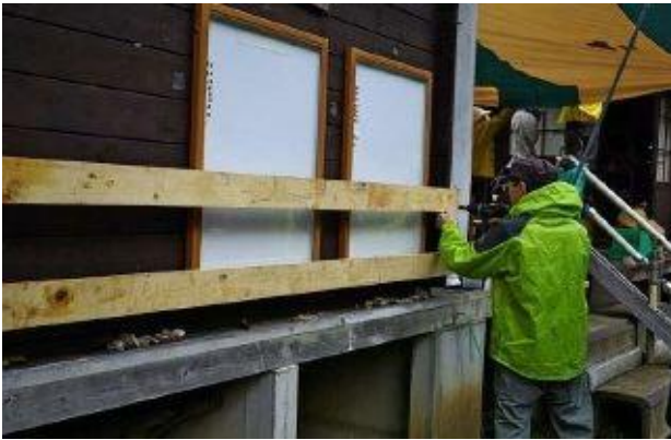
掲示板の雪囲い
