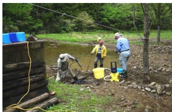
大畑沢取水管閉塞除去
