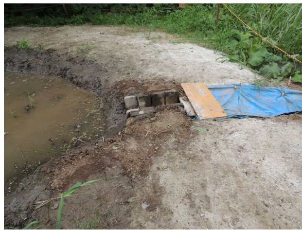
ウルメ池流出口整備完了
