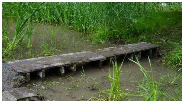
ウルメ池中の島へ渡る木道設置
