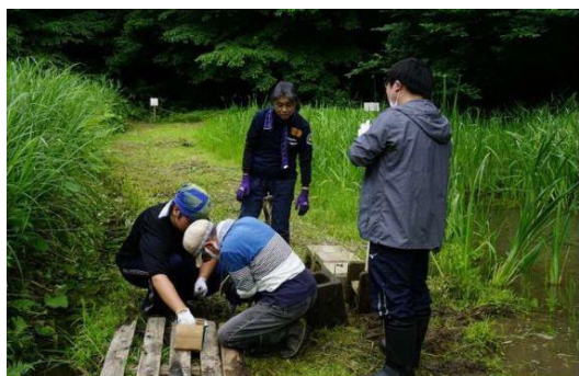
木道敷板の製作
