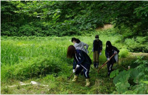
ウルメ池赤沢側漏水箇所補修
