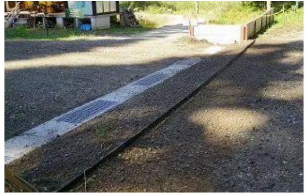
雨水導水用ゴム板敷設完成
