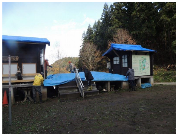
小屋屋根・デッキブルーシート掛け完成
