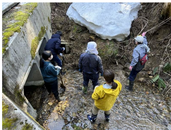
赤沢カナコ菴導水管点検閉塞除去
