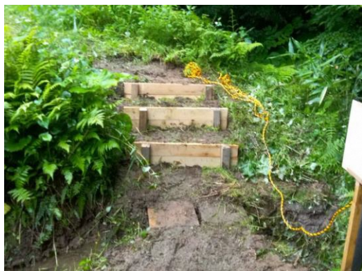
6月29日ウルメ池赤沢側階段設置
