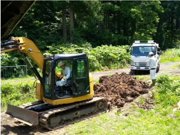
7月4日丸勘建設アプローチ広場土入れ
