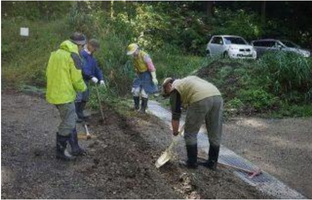
ゴム板を側溝前に埋設
