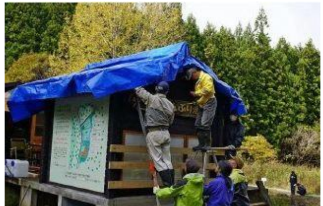
作業小屋ブルーシート掛け
