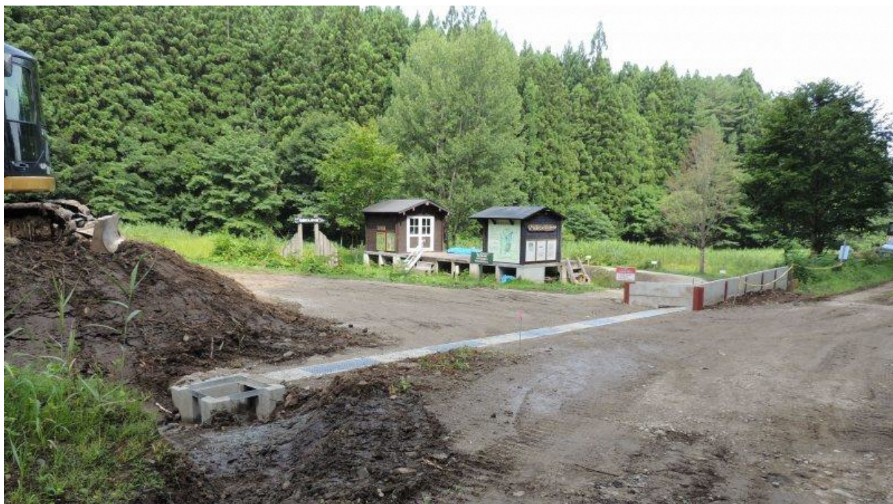
8月5日ルリボシ池集水枡・側溝工事完成
