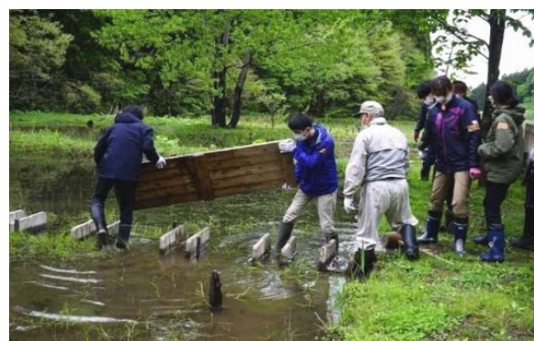
カナコ菴木道敷設
