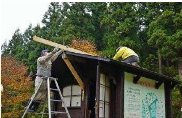
作業小屋屋根に雪割り板の取付け
