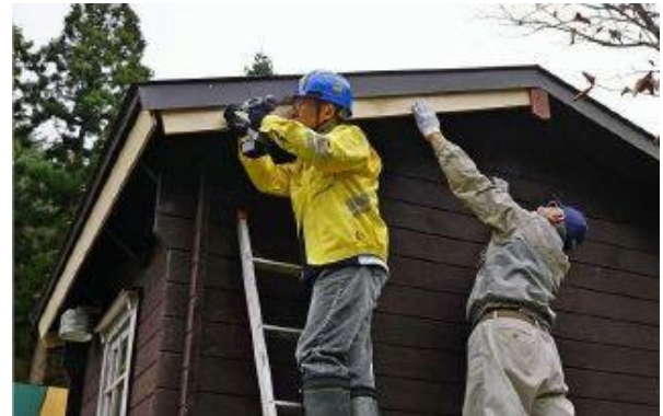
屋根軒下シート押え板の取付け
