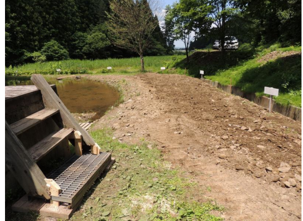
ウルメ池通路整地
