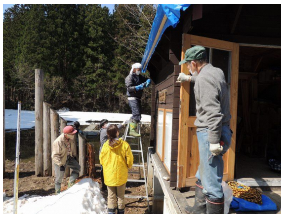
小屋ブルーシートの取外し
