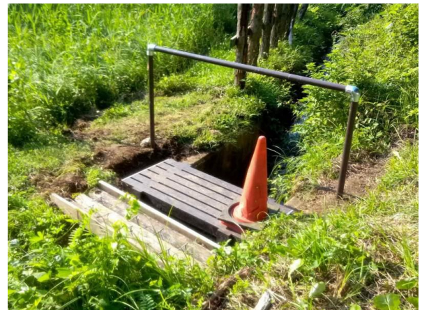
大畑沢渡橋・手摺（片側）完成
