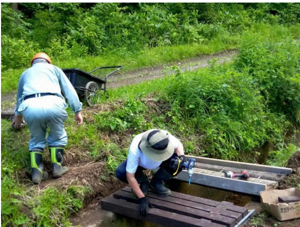
7月11日大畑沢渡橋設置工
