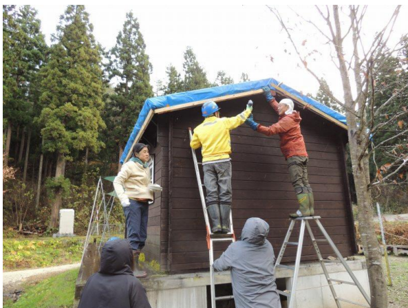
11月11日小屋屋根ブルーシート固定作業
