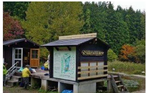
雪割り板の完成
