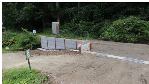
8月5日ルリボシ池集水枡・側溝工事完成
