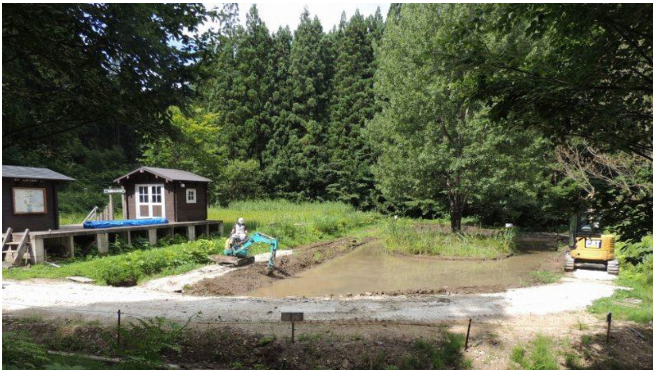
7月27日丸勘建設（株）によるウルメ池浚渫工事状況
