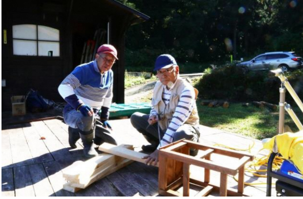
踏板の製作作業
