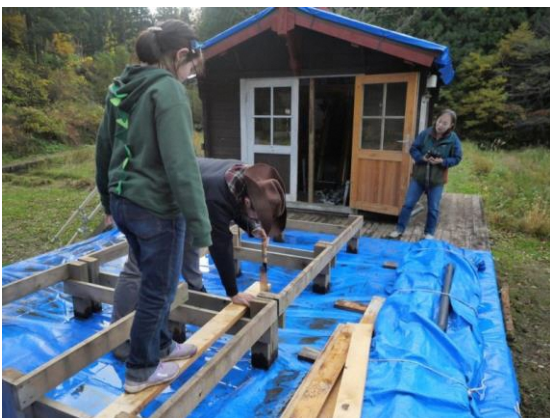
渡橋板材切り出し
