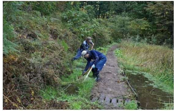
津軽堰の泥上げ
