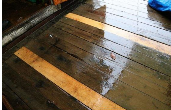
床板の交換完了
