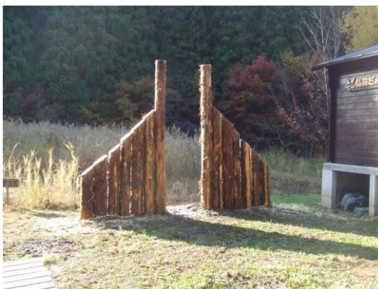
だんぶり池ゲート設置工事
