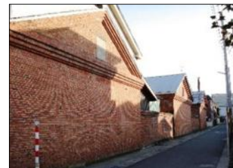
弘前銘醸煉瓦倉庫
