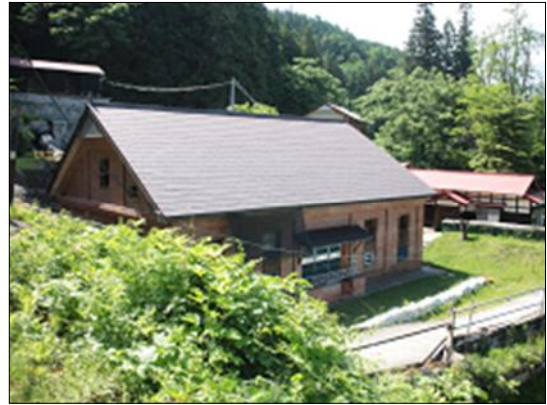
旧福島酒造発電所(吉井酒造発電所)
