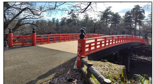
【杉の大橋木部更新完了】
