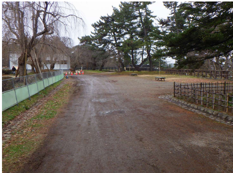
本丸排水工事(着手前)
