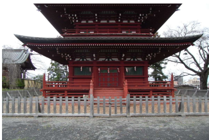
木製保護柵 (現状)
