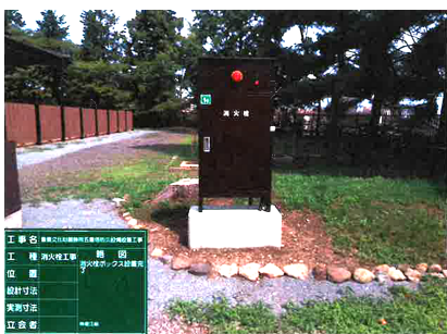
易操作性消火栓設置
