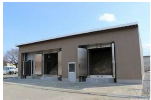
図 8-29 岩木庁舎の雪室導入事例
