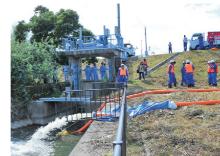
緊急排水訓練（8月） 令和4年8月の大雨による浸水被害を受け、市は県内初の移動式大容量排水ポンプシステムを導入。排水作業手順を確認しました。
