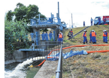
緊急排水訓練（8月） 令和4年8月の大雨による浸水被害を受け、市は県内初の移動式大容量排水ポンプシステムを導入。排水作業手順を確認しました。
