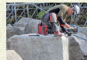
（※5）交換石の仕上げ加工
