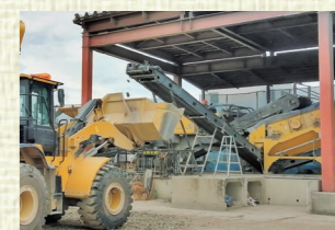
（※7）破砕機で角礫に加工
