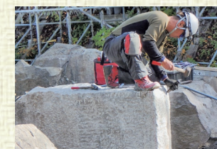
（※5）交換石の仕上げ加工
