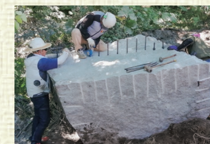
（※3）調達した石材の粗割り作業
