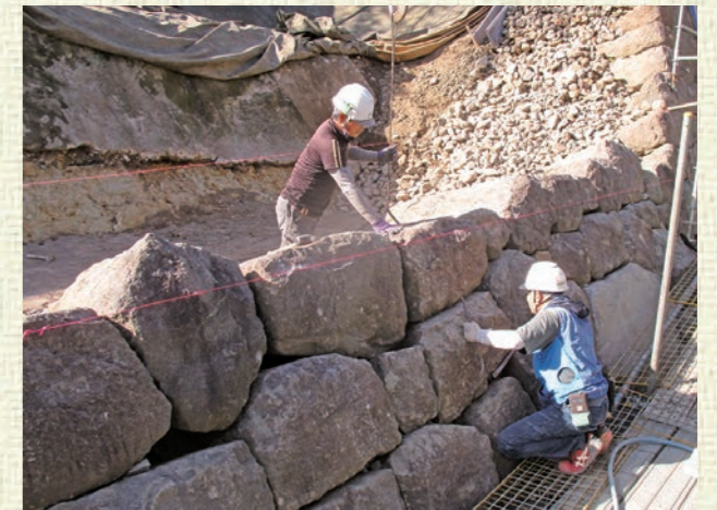
▲（※3）丁張（ちょうはり）と石積み作業
