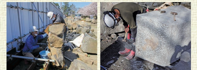
▲（※4）割れた石の補修 ▲（※5）交換する石の加工
