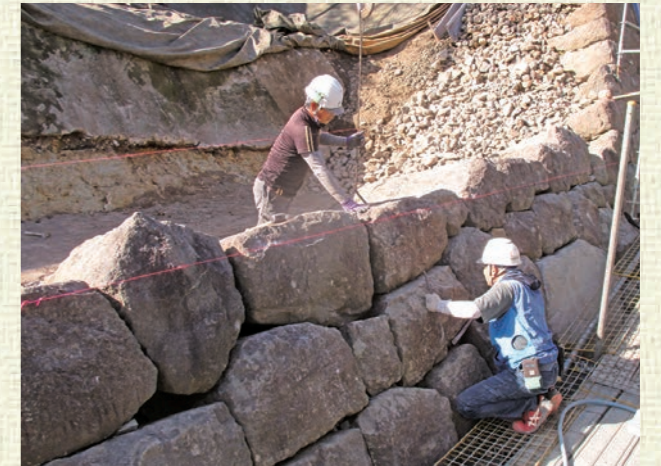
▲（※3）丁張（ちょうはり）と石積み作業
