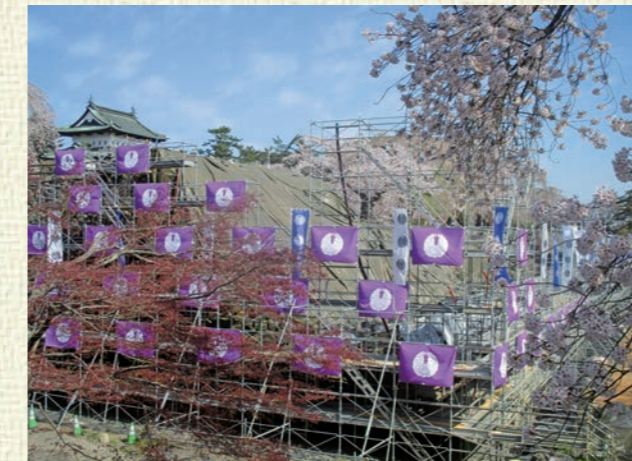
▲（※2）本丸東面石垣工事現場（令和6年4月23日時点）
