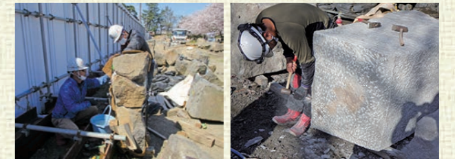
▲（※4）割れた石の補修 ▲（※5）交換する石の加工
