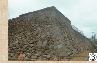
①石垣解体および発掘現場全景（平成30年）／②発掘調査で新たに発見された埋没石垣（平成30年）／③勾配、反りが江戸時代の姿によみがえった本丸石垣（令和7年）
