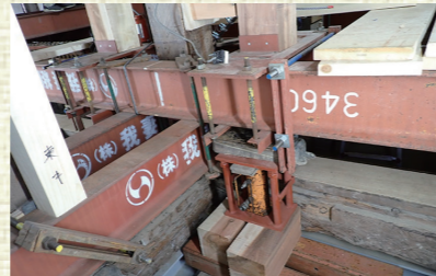
▲(※4) 揚家用ジャッキ設置状況
