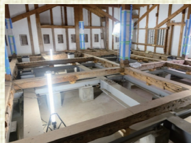
▲(※3) 仮補強鉄骨と床板の取外し(天守1階)
