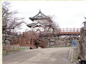
▲(※2) 仮設通路の設置
