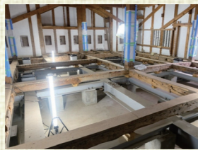
▲(※3) 仮補強鉄骨と床板の取外し(天守1階)
