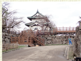
▲(※2) 仮設通路の設置
