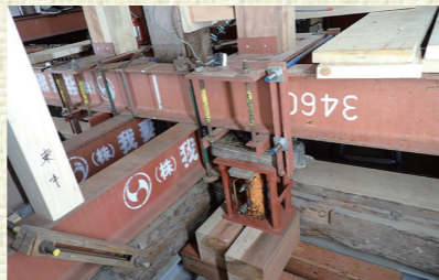
▲(※4) 揚家用ジャッキ設置状況
