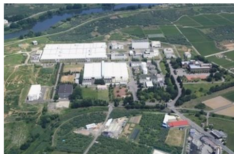
岩木川浄化センター処理場全景（青森県）
