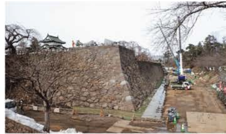
完成した石垣 (令和6年)
