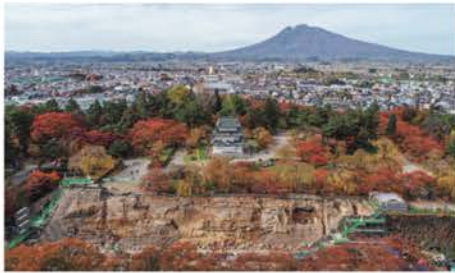
石垣解体後の本丸 (平成30年)
