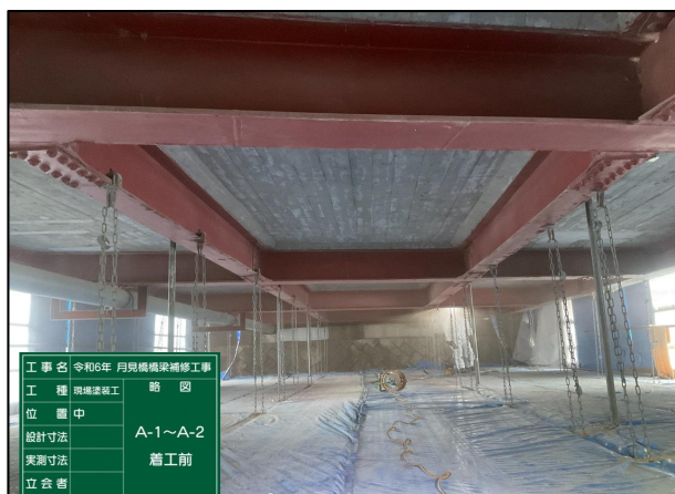
橋梁塗装工 着工前
