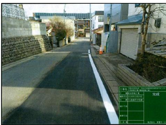
完成（給水管引込部）
