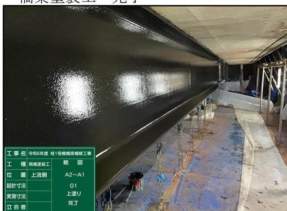
橋梁塗装工 完了
