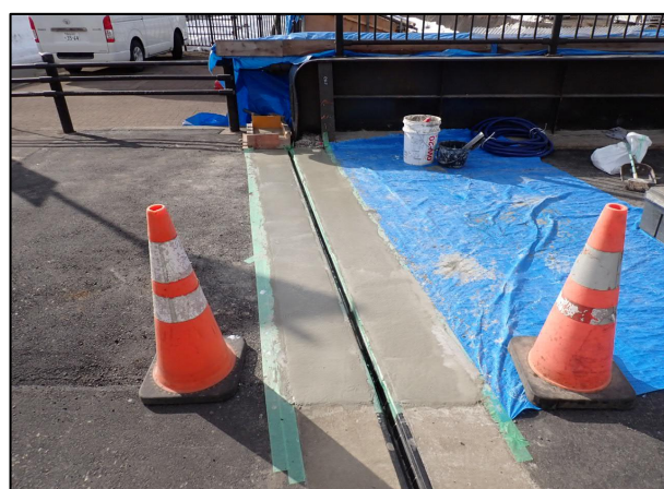
伸縮継手工（伸縮装置）完了
