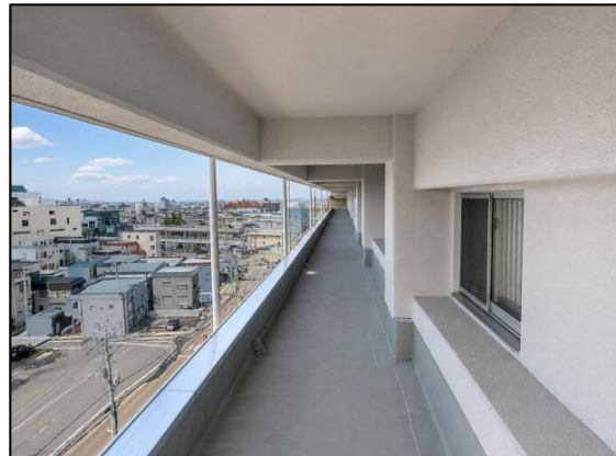
防水改修・外壁改修工事（廊下屋根） 完成
