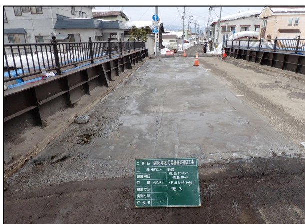
橋面防水工（浸透系防水材：1層目）完了
