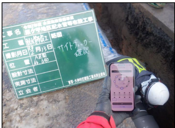
配水管布設工 施工管理システム活用状況
