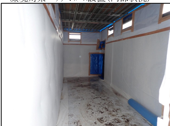
環境対策 クリーンルーム設置(内部状況)
