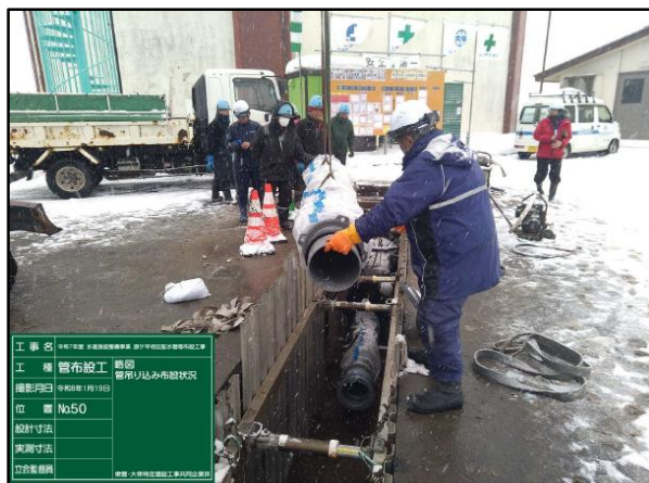
流入管布設工 管吊り込み状況
