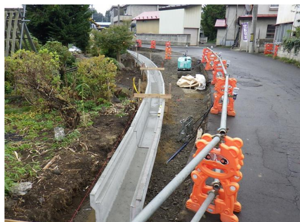
排水構造物工 U型側溝設置完了
