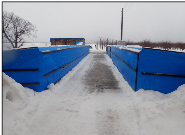
橋梁足場工 設置完了
