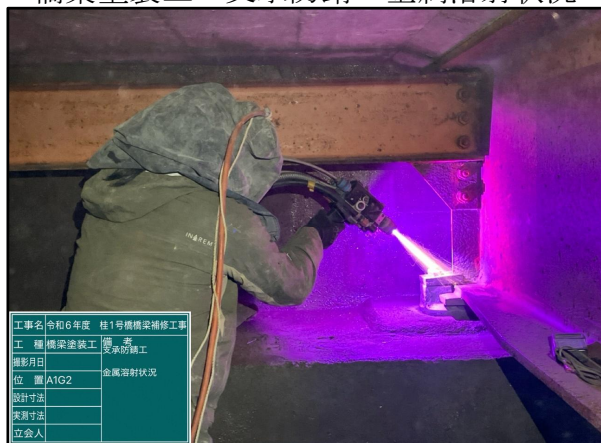
橋梁塗装工 支承防錆 金属溶射状況
