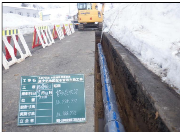
配水管布設工 管布設状況
