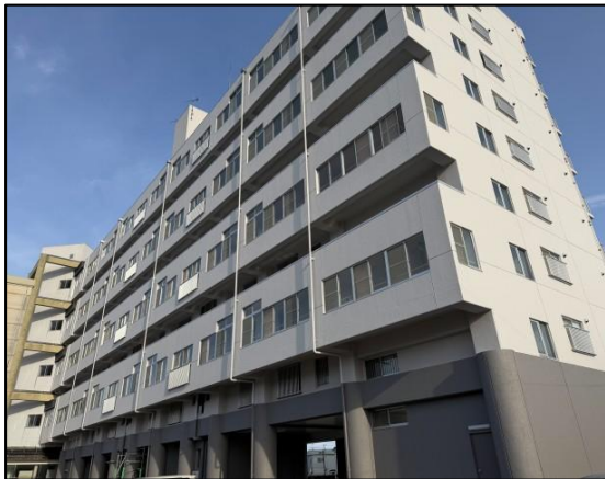
外壁改修工事（北面） 完成
