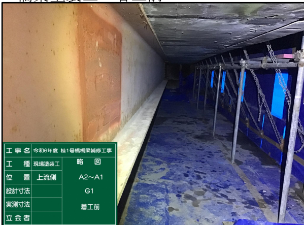
橋梁塗装工 着工前
