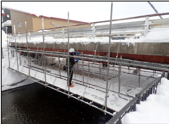
橋梁足場工 吊足場設置状況
