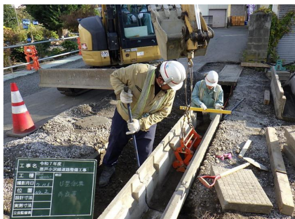
排水構造物工 U型側溝設置状況
