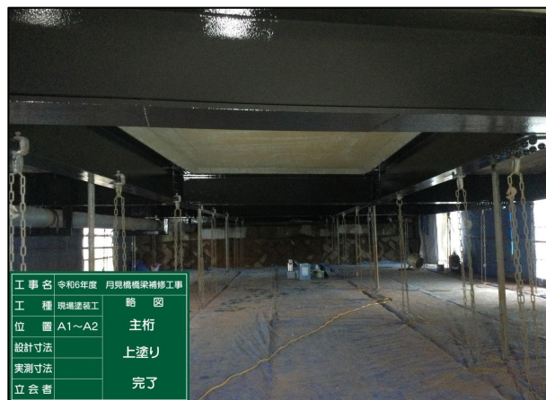
橋梁塗装工 完了
