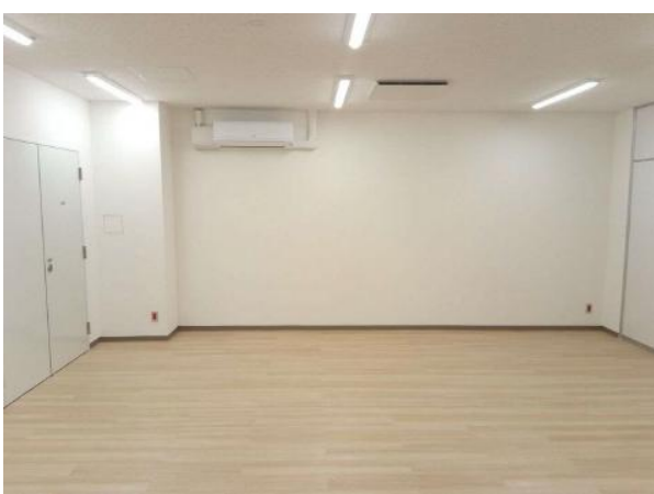
完成（サーバー室）
