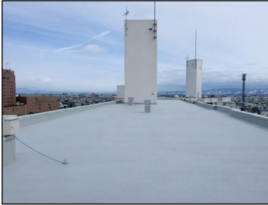
防水改修工事（屋上） 完成
