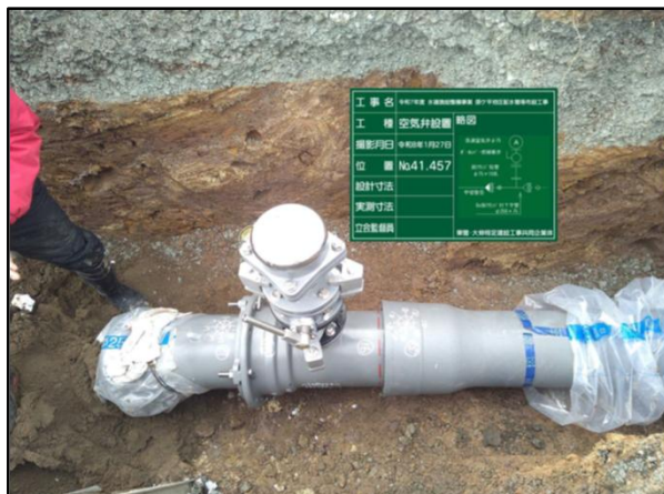
空気弁設置工 設置状況
