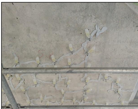
外壁躯体補修工事 作業中
