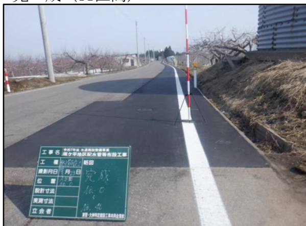
完 成 (A区間)
