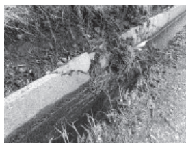
側溝が破損している
